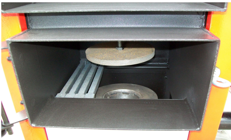
Widok na żeliwny palnik retortowy (11).
