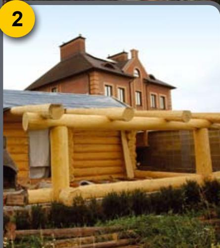
Параллельно с работой по срубам закладывался фундамент. В данном случае был использован ленточный фундамент. Когда фундамент был готов, и его можно было нагружать, на строительную площадку к заказчику доставили уже готовые заготовки сруба.
